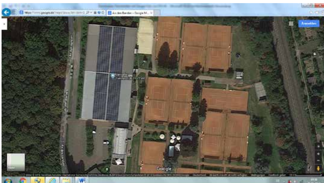
Lintorfer TC 1972 e.V. (840 PV-Module mit 170.000 kWh Leistung p.a.)
